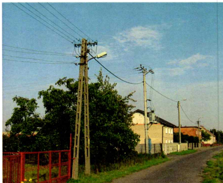
Fot. 5. Linie dystrybucyjne nn-0,4 kV (przykłady)
